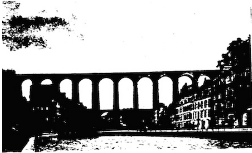
Le viaduc de Morlaix.
