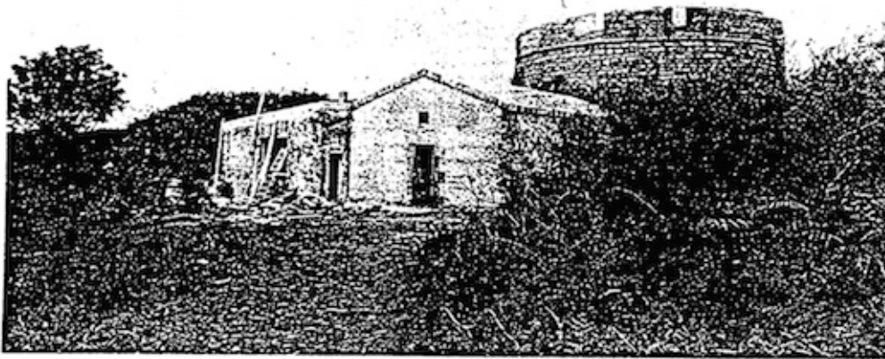
Les créneaux de la tour sont débouchés, le toit de la poudrière est refait...
