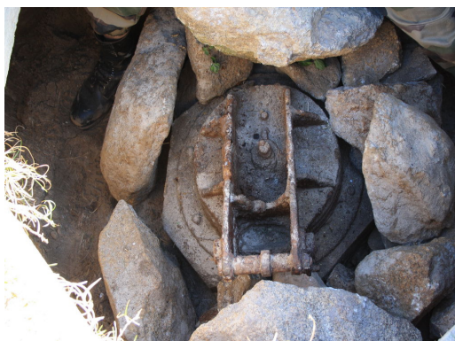
Dispositif de fixation du patin du mortier
